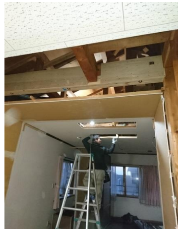
④ 天井が開いている間に、南側洋室の天井付エアコンを移動させます。
